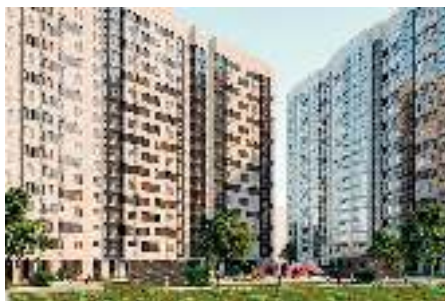
г. Москва, ул. Осташковская, вл. 9/2 Узел коллекторный для отопления – 1091 шт. Теплосчетчик – 551 шт. Счетчик воды – 1420 шт.
