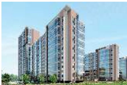
г. Санкт-Петербург, ЖК «Чистое небо», д. 13, к.3 Счетчик воды – 7900 шт.
