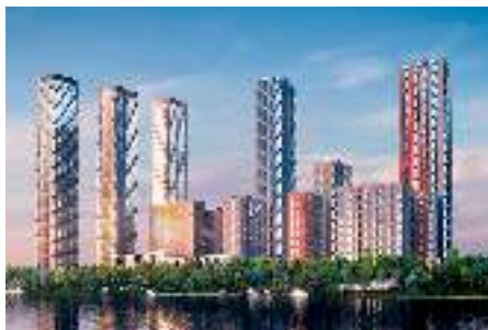
г. Москва, ЖК «Сiti Vaу», к. 1 Узел коллекторный для отопления – 219 шт. Теплосчетчик – 90 шт. Счетчик воды – 4725 шт.
