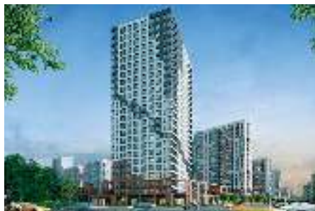
г. Санкт-Петербург, ЖК «Стрижи в Невском 2», к.1 Теплосчетчик – 1591 шт. Счетчик воды – 5279 шт. Электросчетчик – 144 шт.
