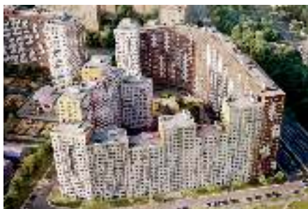
г. Москва, ЖК «Румянцево-Парк», д.3 Теплосчетчик – 1794 шт. Счетчик воды – 5778 шт.
