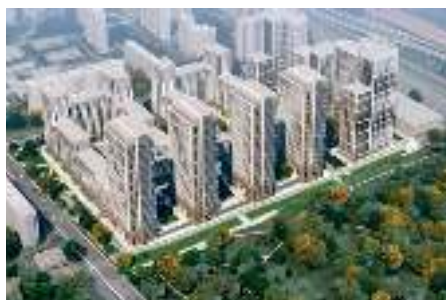
г. Москва, ул. Клинская, вл.2 к.1 Узел коллекторный для отопления – 104 шт. Теплосчетчик – 1085 шт. Счетчик воды – 2160 шт.
