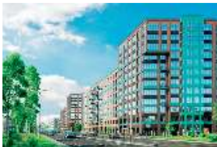
г. Санкт-Петербург, ЖК «Панорама парк Сосновка», д.5 Теплосчетчик – 6 шт. Счетчик воды – 5414 шт.
