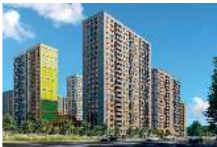
г. Москва, ЖК «КутузовGRAD», к. 5 Узел коллекторный для отопления – 159 шт. Теплосчетчик – 214 шт. Счетчик воды – 918 шт.
