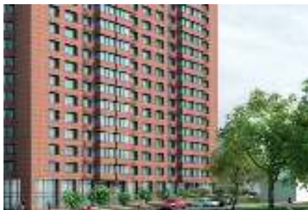
г. Москва, Бескудниковский р-н, кв. 8, 9, корп. 32 Узел коллекторный для отопления – 637 шт. Теплосчетчик – 214 шт. Счетчик воды – 1213 шт.
