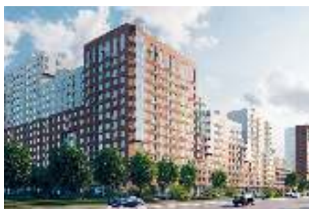
Московская обл., ЖК «Новомилино», к.1 Узел коллекторный для отопления – 109 шт. Теплосчетчик – 729 шт. Счетчик воды – 1726 шт. Электросчетчик – 11 шт.
